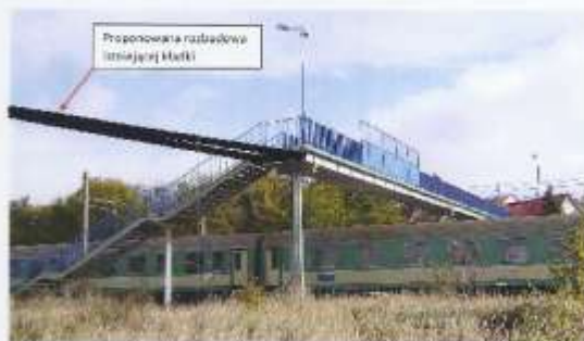
Zdj. Nr 6 – widok istniejącej kładki od strony ul. Ułanowskiej.
